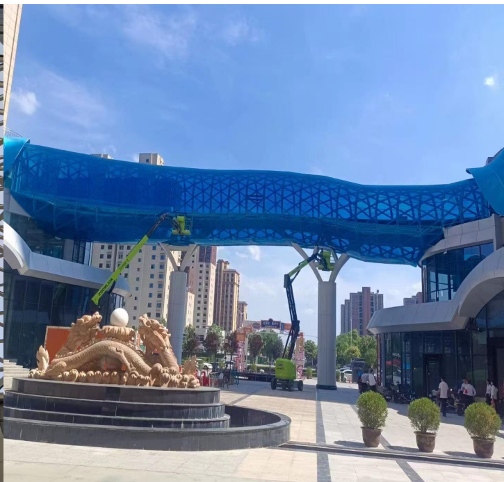
近期工程实景照片
