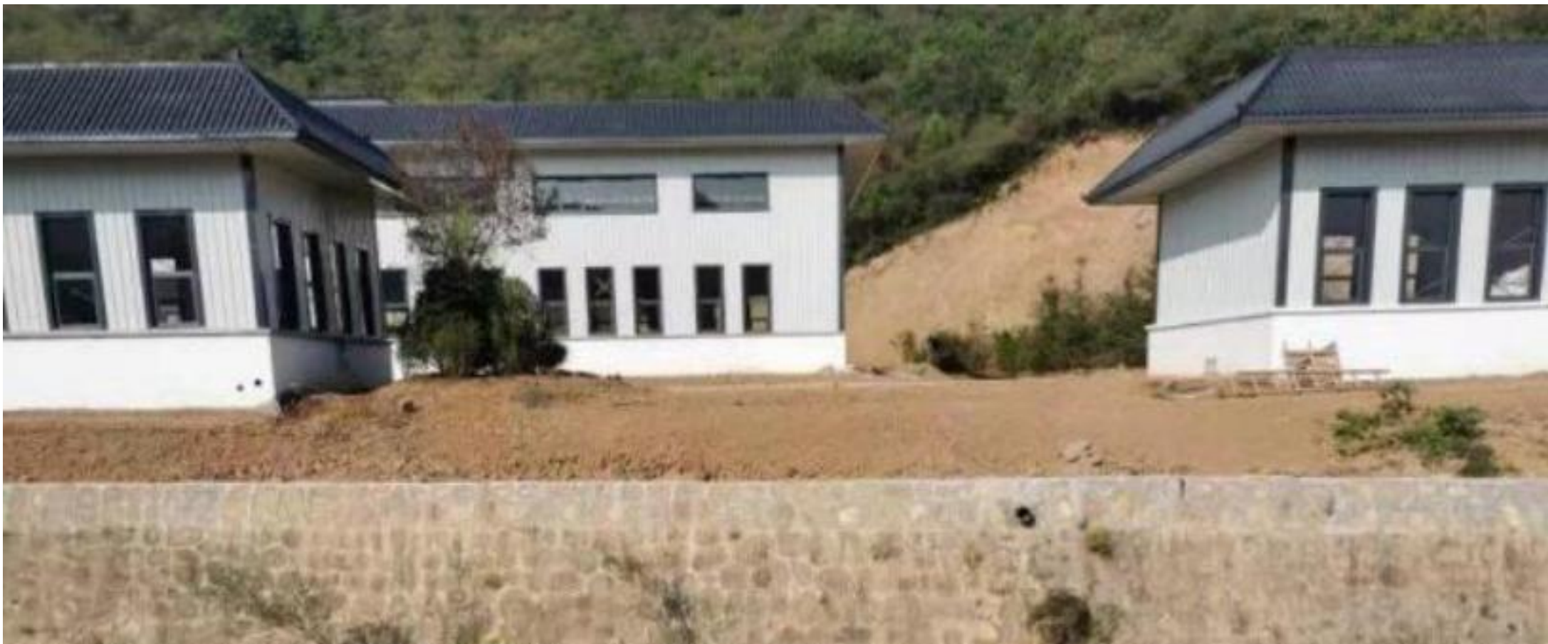
近期工程实景照片
