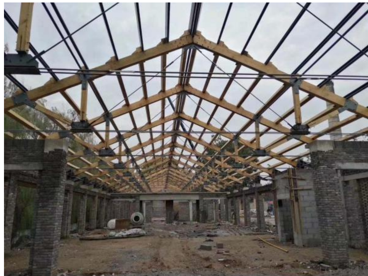
近期工程实景照片
