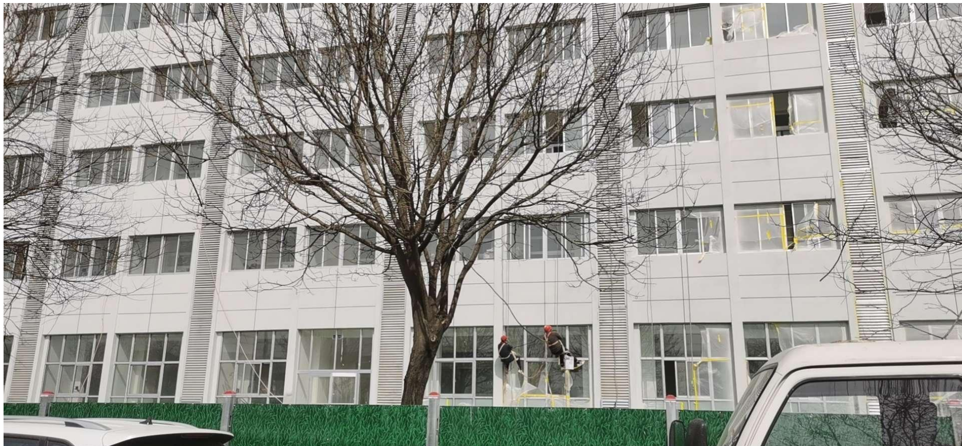
近期工程实景照片
